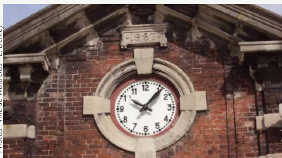
Photos : Ville de Wattrelos - E. Derrey
