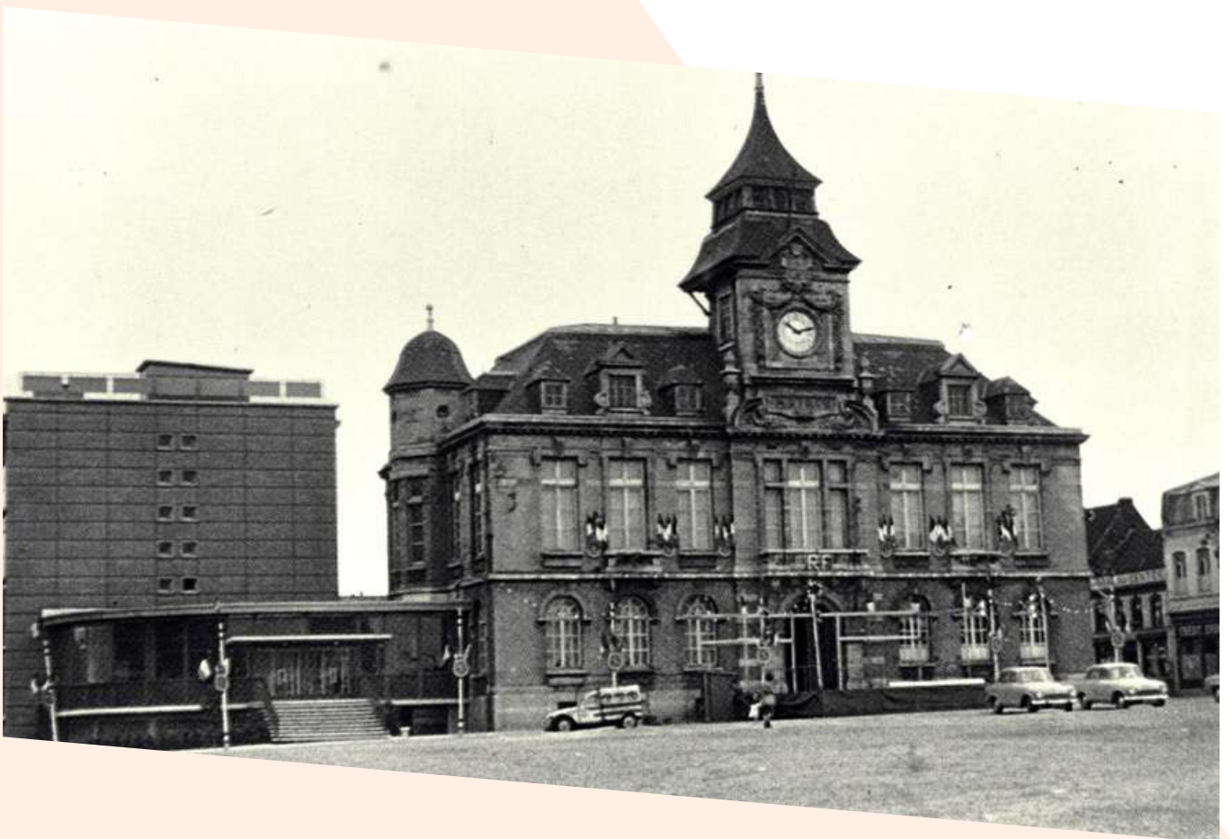
Hôtel de Ville après les travaux d'agrandissement
